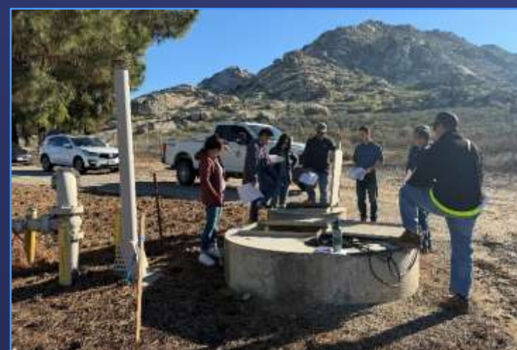
Perris PCS Effluent
