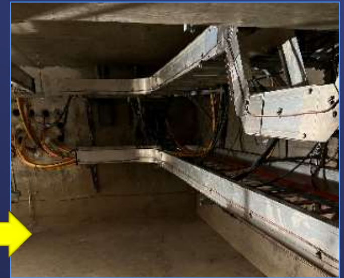
New Cables & Cable Trays
