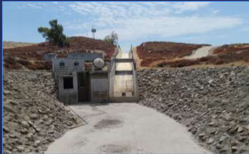
Lake Skinner Spillway
