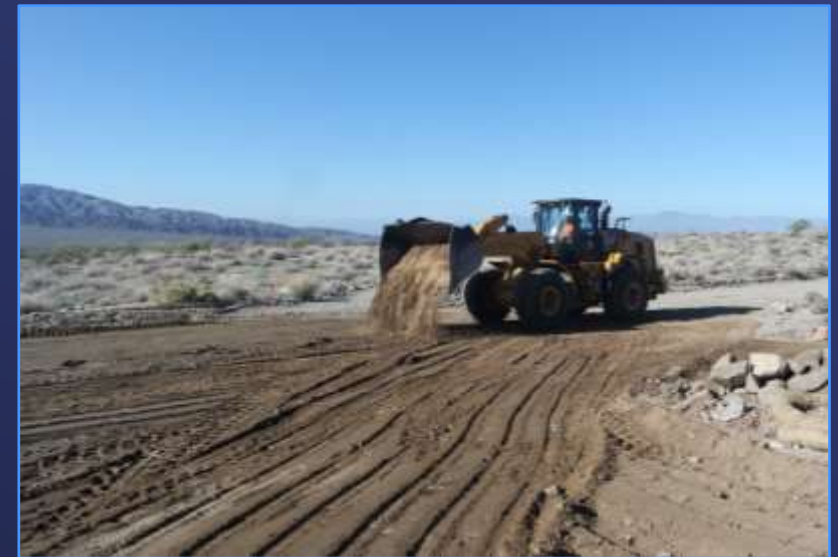
CRA Conduit Structural Protection
